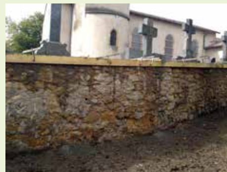
Le mur et les escaliers côté presbytère vont être refaits à neuf
