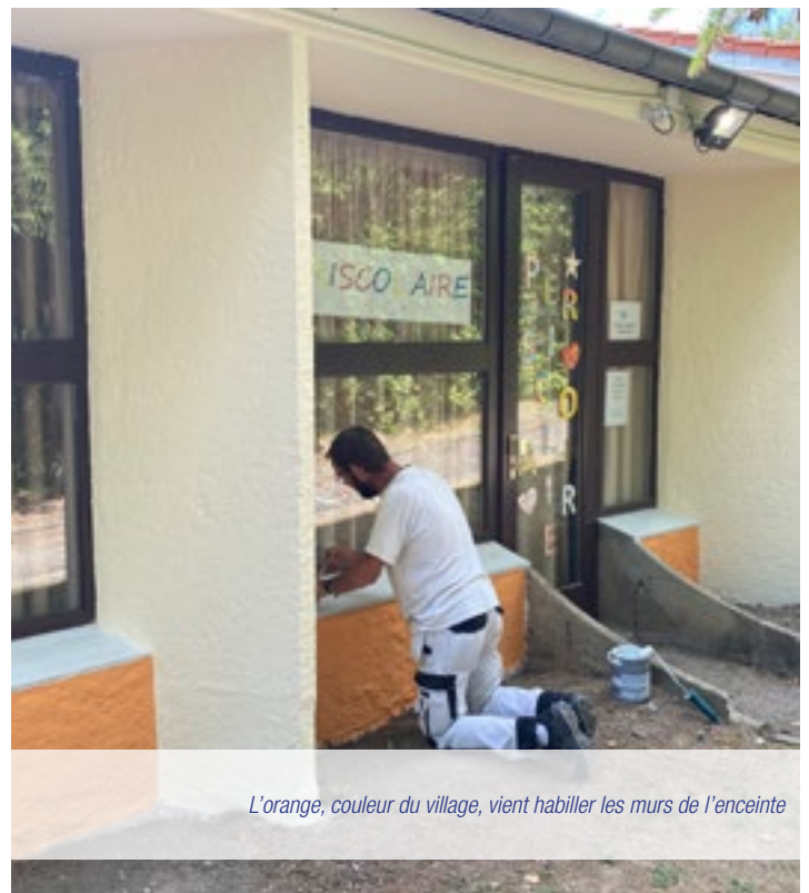
Sébastien Deitz, l'ouvrier communal a prêté main forte aux entreprises
